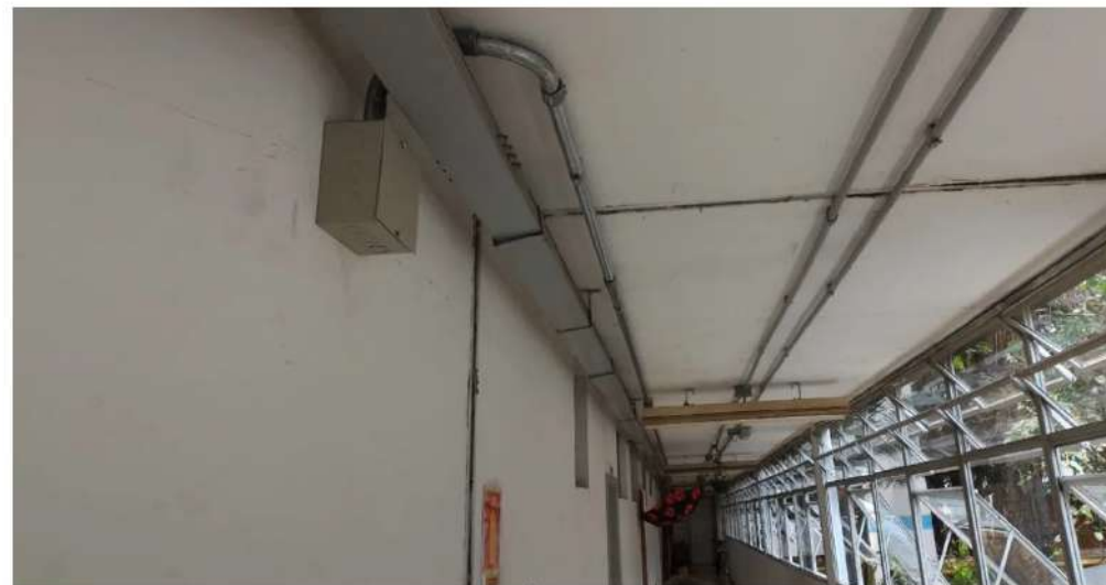
Instalação dos dutos externos para passagem dos cabos que levarão o sinal de internet ao interior dos apartamentos – Foto: Divulgação SAS
